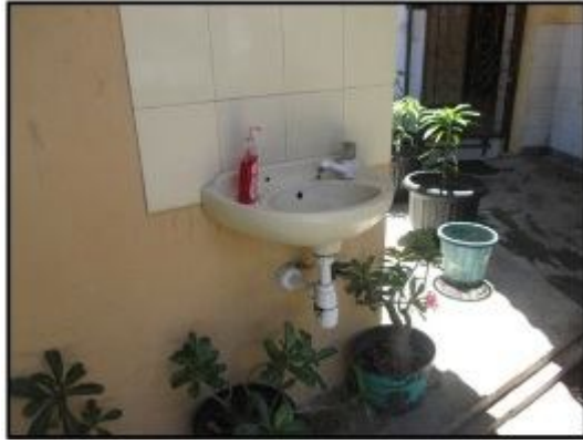
WASTAFEL DI TEMPAT STRATEGIS DILENGKAPI SABUN
