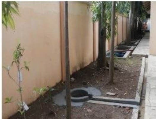
SUMUR RESAPAN DI SUDUT SEKOLAH
